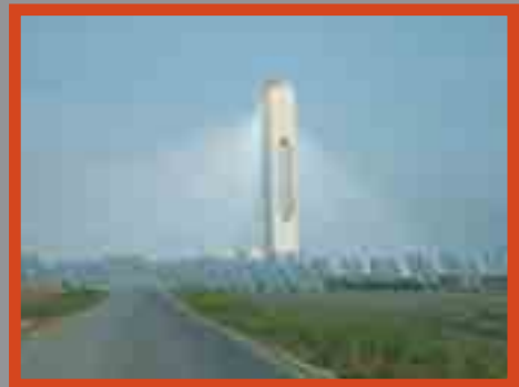
Central termoelèctrica solar a Sanlúcar la Mayor (Sevilla).
